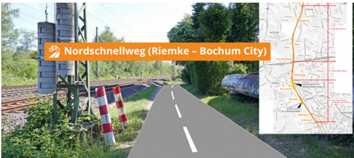
Der Radweg sollte 3 m breit sein, so wie es die Empfehlungen für Radverkehrsanlagen (ERA 2010) für den Bau von Zweirichtungsradswegen vorsehen.
