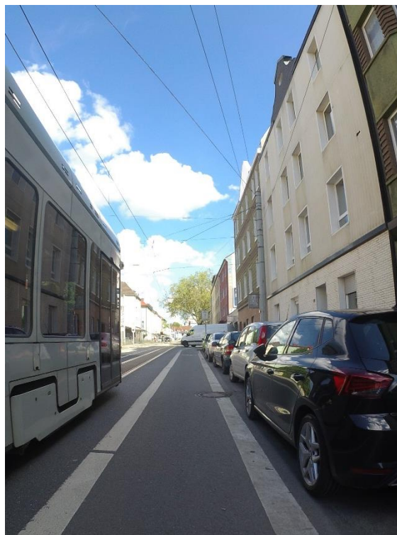
Abbildung 24: Radfahrstreifen auf der Dorstener Straße
