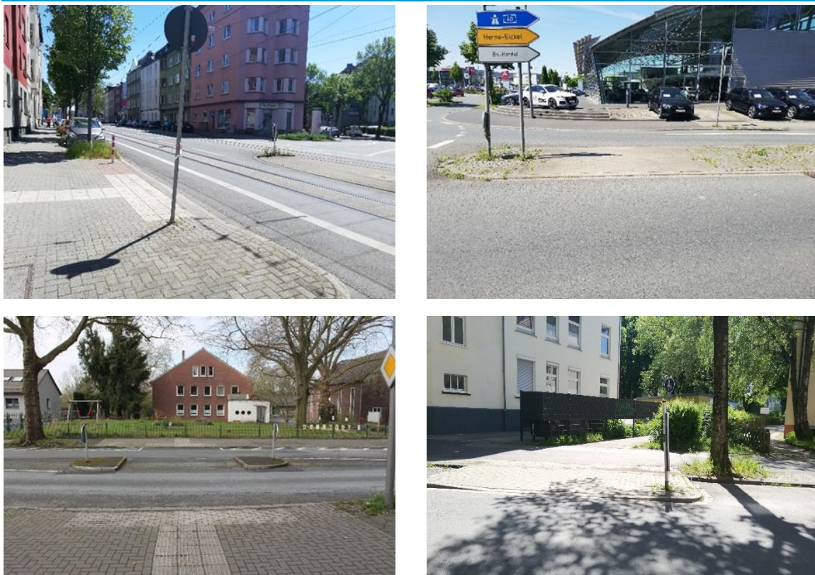
Abbildung 14: Gehwegaufweitungen an Querungsstellen
